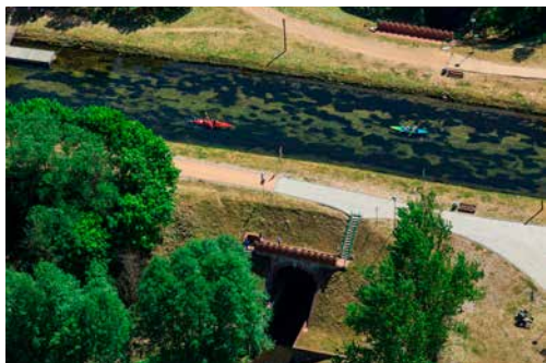
AKWEDUKT W FOJUTOWIE
