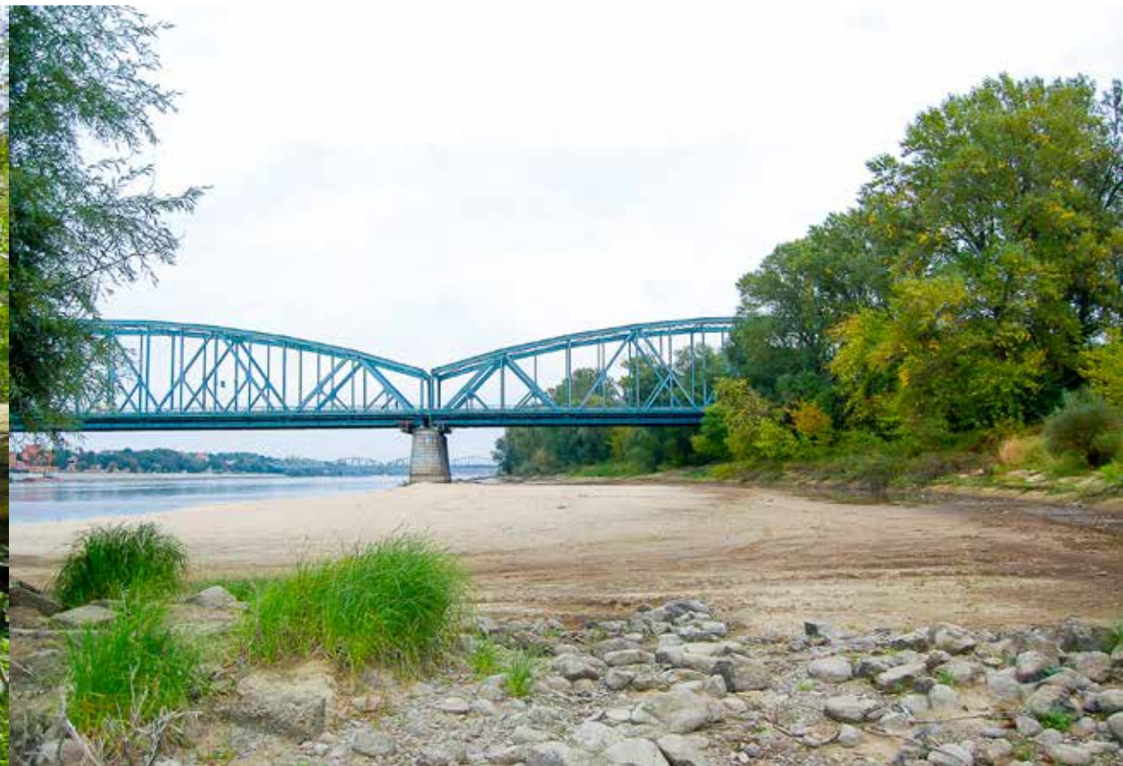
WIDOK Z KĘPY BAZAROWEJ NA MOST DROGOWY PRZY BARDZO NISKIM STANIE WODY W WIŚLE
