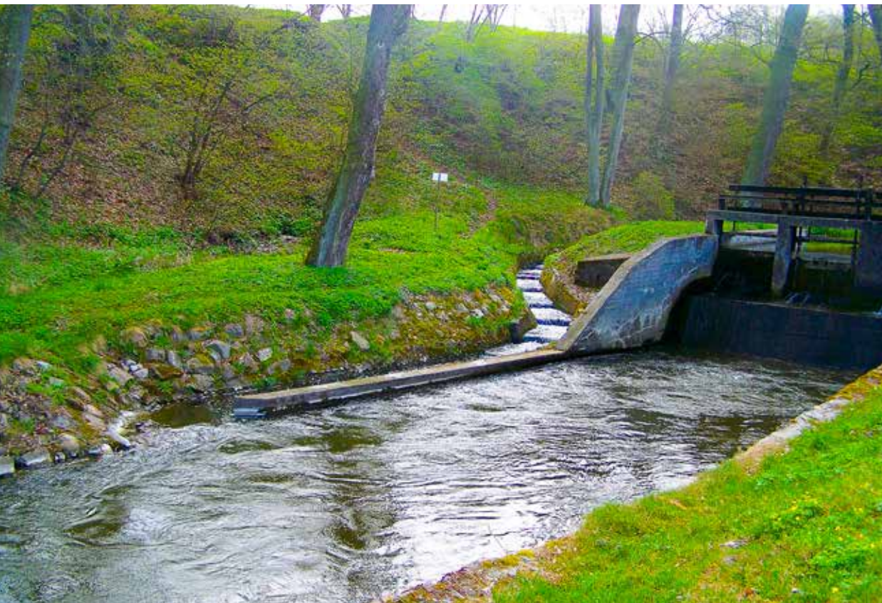
FOT. 2 STOPIEŃ WODNY Z PRZEPŁAWKĄ DLA RYB – WIDOK OD STRONY WODY DOLNEJ
