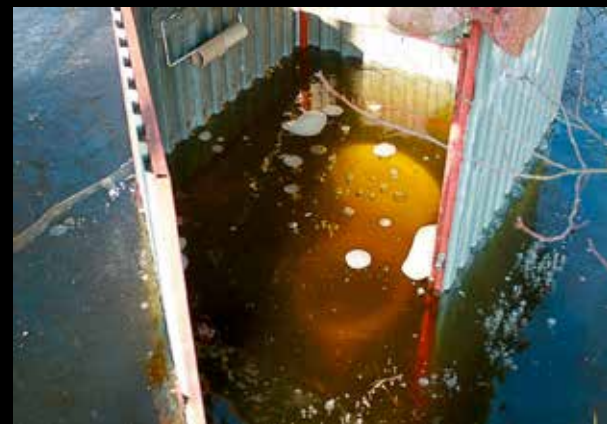
FOT.5. ŚETKI ZALANYCH SAMOWOLI BUDOWANYCH BOMBĄ EKOLOGICZNĄ Z OPÓŹNIONYM ZAPŁONEM
