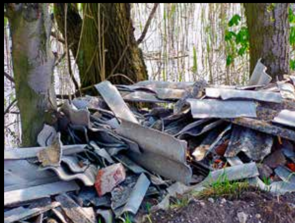
FOT.2. ZASYPIWANIE J. GOPŁA ETERNITEM I ŚMIECIAMI W TRAKCIE PRZEBUDOWY DRÓGI
